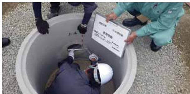
水理性能 施工試験
